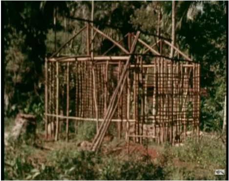
Ossature (Placement des Poutres (Nguidzo), Mur en bambou et tiges de raphia.
