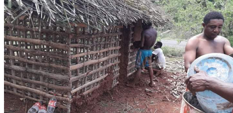
Remplissage de l'ossature avec le torchis.
