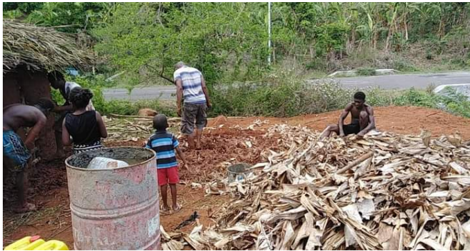
Mélange de la terre avec des feuilles de bananier (préparation du torchis).
