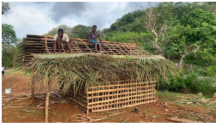
Mise en place de la toiture en feuilles de cocotier.
