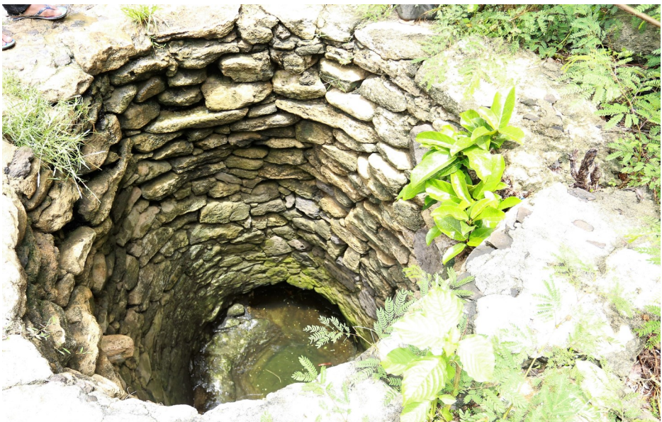
Puits situé l'îlot M'tzamboro construit avec du soy
