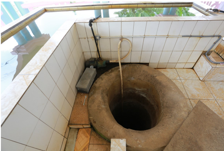
Puits et bassin d'ablution situé à la mosquée d'Iloni
