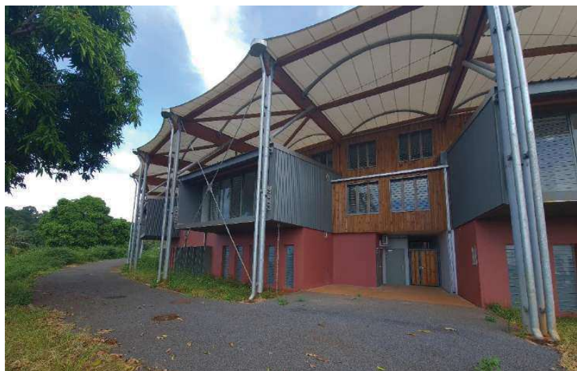
Zone d'accès laboratoire
